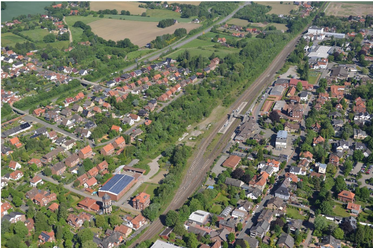
Luftbild Bahnhof Bramsche (Quelle: Stadt Bramsche).
